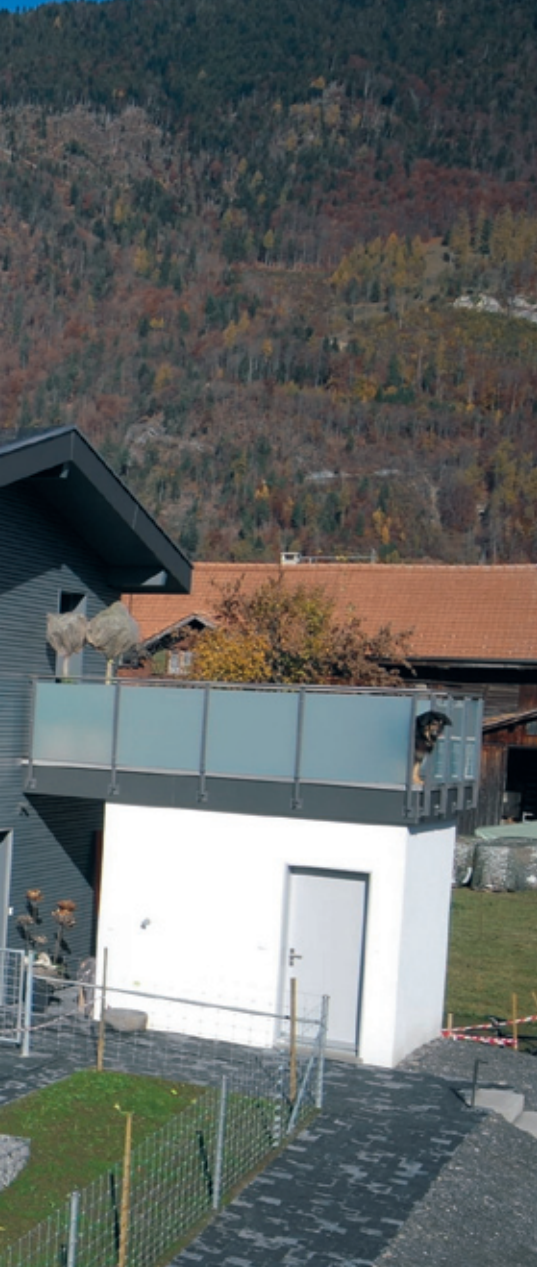
Ein Haus als Kraftwerk
